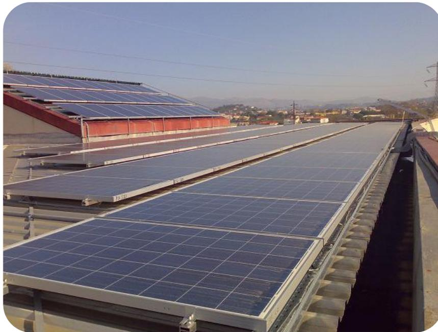
Impianto fotovoltaico realizzato a Formia (LT) con 180 pannelli schuco da 200 W, 4 inverter schuco 5000 e 3 inverter schuco 4500
